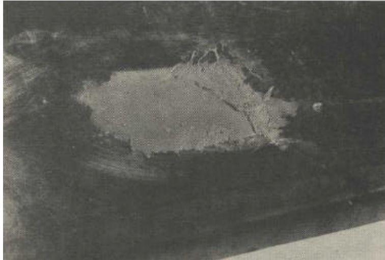
Bild 12 Loch mit Blech hinterklebt und mit Klebmasse ausgefüllt
