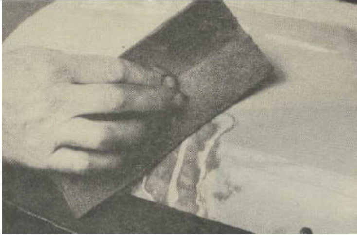
Bild 9 Abschleifen des überstehenden Klebers
